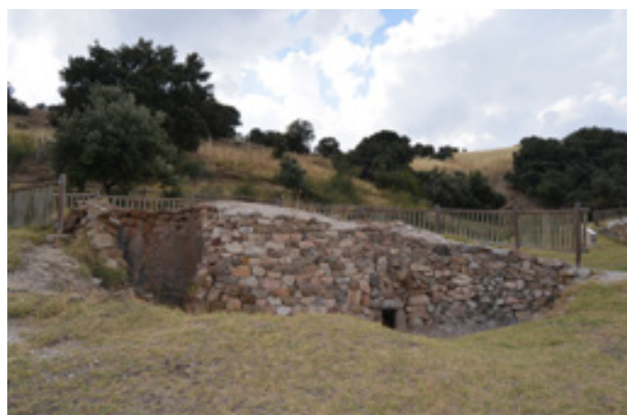
Horno de cal construido con la técnica de piedra en seco, reconocida por la UNESCO como Patrimonio de la Humanidad recientemente. Vegas de Matute. Parque arqueológico Hornos del Zanco. Foto. E. Maganto, sept. 2018.
